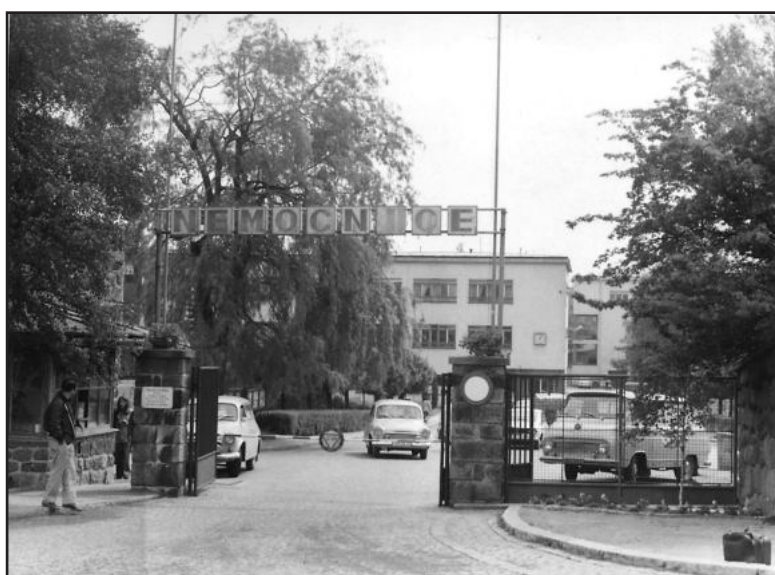
STARÉ A NOVÉ. Původní vrátnice s ručním otevíráním a současný moderní vstupní pavilon.
