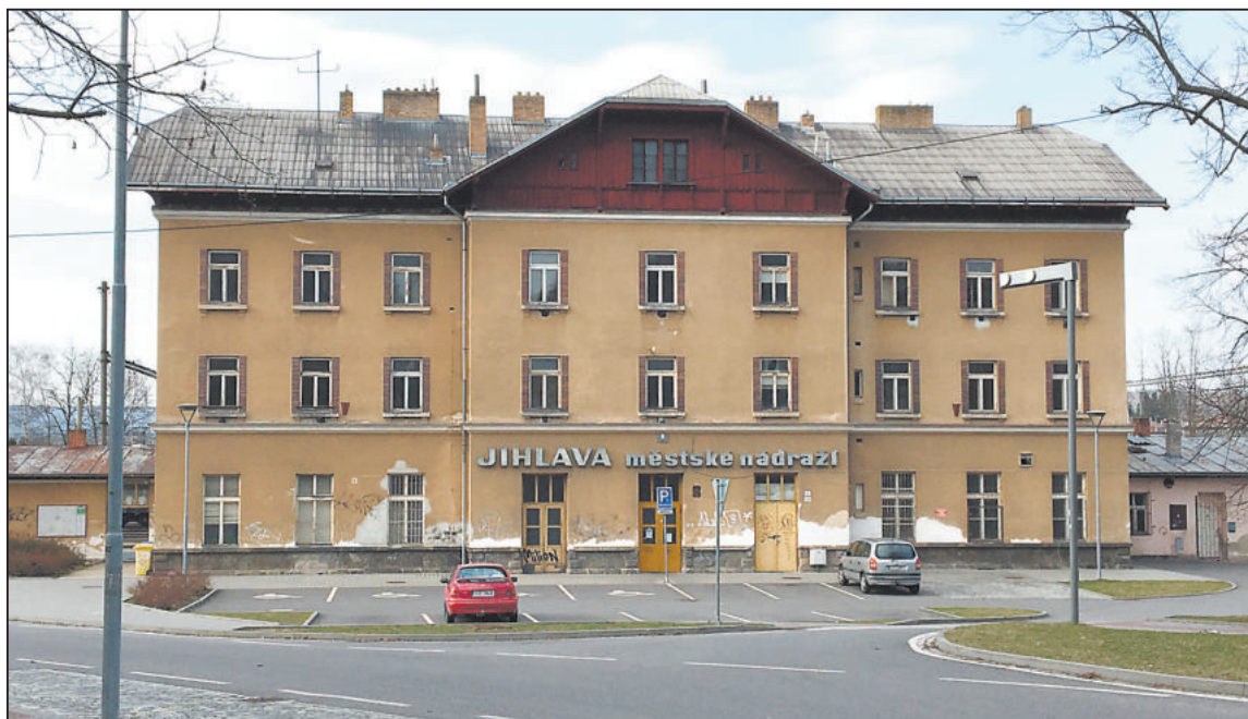
NA HORNÍM snímku nová budova městského nádraží, na spodním ta stávající, která by dle plánu mohla jít k zemi již v letošním roce. Foto: archiv město Jihlava, archiv JI
